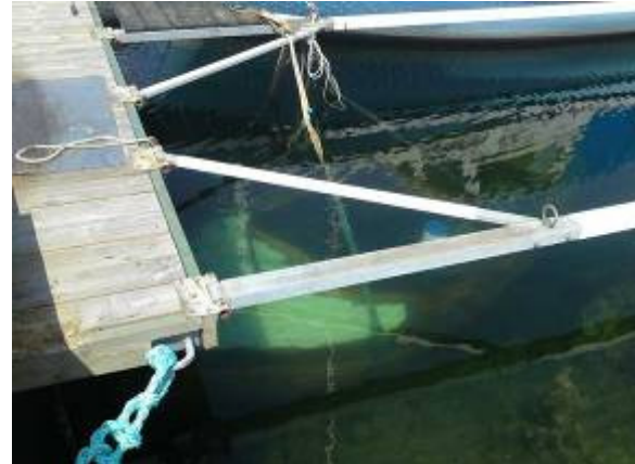
J10 nr 293 som låg i marvatten, men så stannade pumpen.
