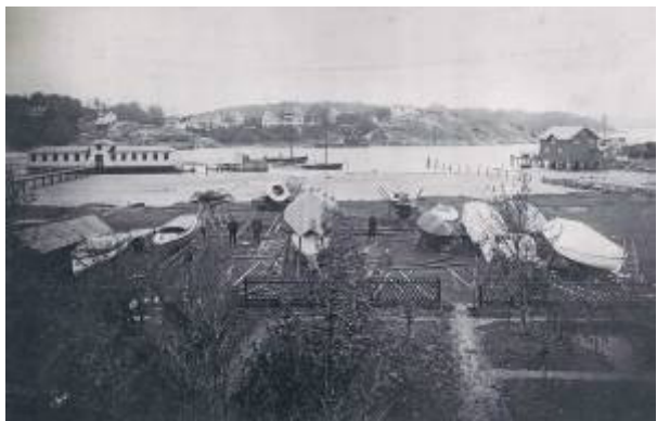
Gräsplanen ned mot vattnet. Utfyllt och asfalterat i dag. (Se nedan)
