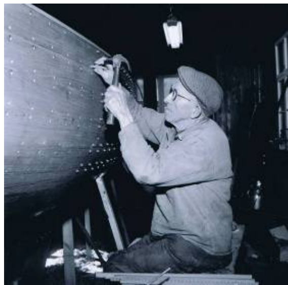
Säker hand säkert öga, var rubriken till denna bild i tidningen. Propning kallas det här jobbet som Gustav Karlsson 71 år gör.
