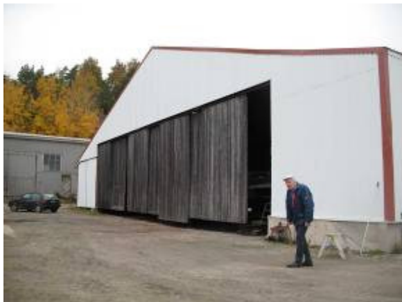
Nils vid Munkeby Varv i Dragsmark. Stora hus för båtförvaring.
