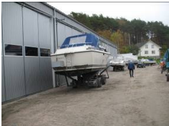
Nybyggda lokaler för vinterförvaring av båtar på Dragsmarks Varv.
